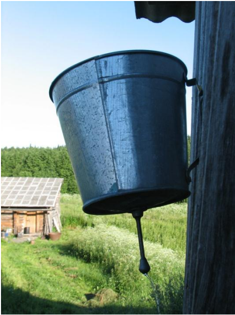
Juokseva vesi PuuCee:n seinässä
